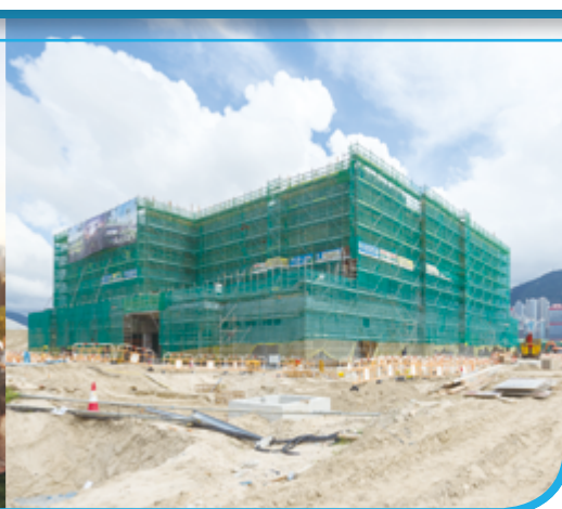
Freespace officially topped-out 自由空間正式平頂
